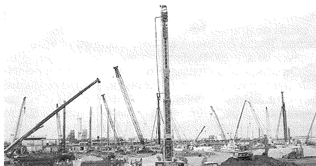
FIG. 13 Exécution parallèle de pieux battus, de pieux forés et de colonnes ballastées (Keller Fondations Spéciales, 2009). Parallel execution of driven piles, bored piles and stone columns (Keller Fondations Spéciales, 2009).
