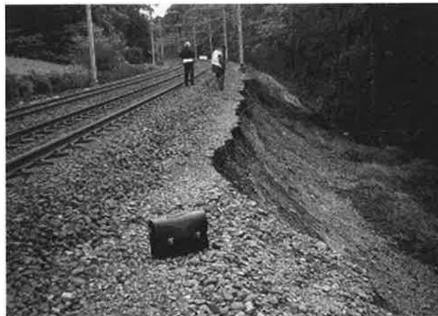
FIG. 1 Glissement d'un talus de remblai.
