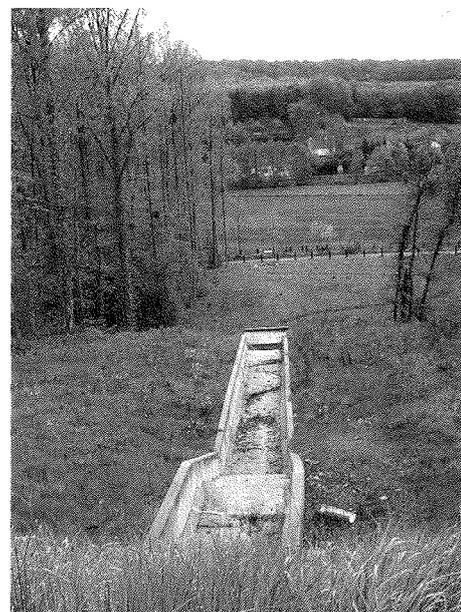
**FIG. 11** Exutoire d'un drainage transversale de remblai.
