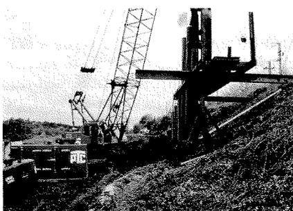
Vue générale du chantier avec la grue mettant en œuvre les palplanches.
