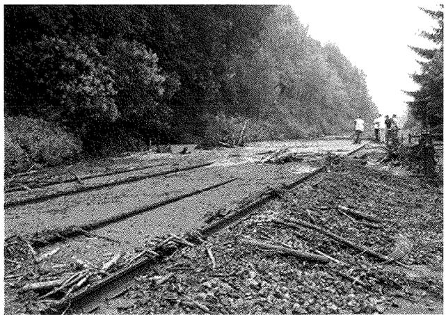
**FIG. 3** Coulée boueuse sur plate-forme ferroviaire.
