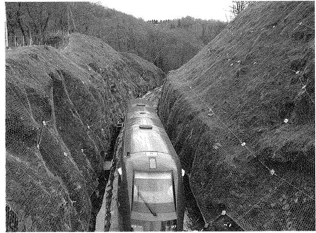
**FIG. 15** Revêtement grillagé sur une tranchée rocheuse.
