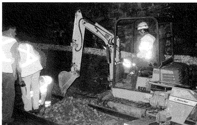
FIG. 5 Fouille mécanisée en plate-forme.
