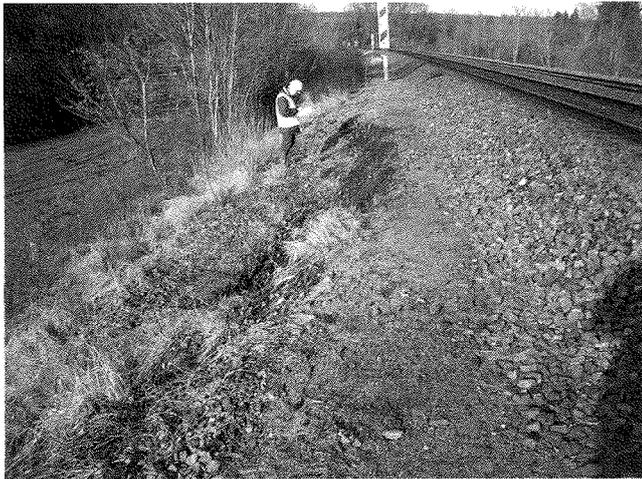
**FIG. 2** Incident en remblai de type glissement.
