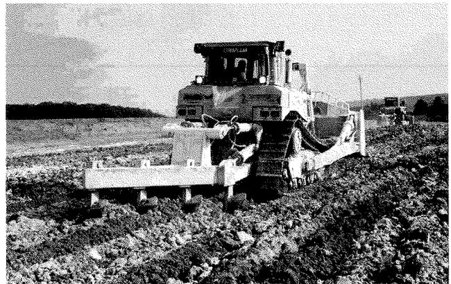
FIG. 6 Traitement à la chaux réalisé à la charrue à socs tractée par un buteur.
