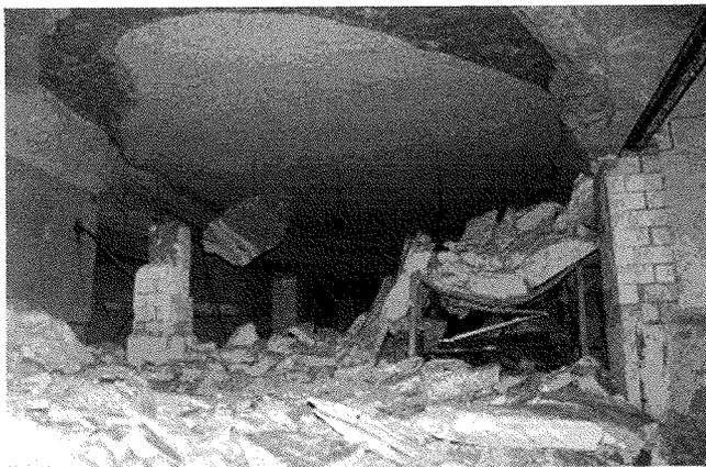
**FIG. 2** Exemple de chute de toit dans une carrière de calcaire grossier (Septmonts, Oise).
