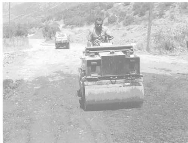
**FIG. 5 Compactage des couches de remblai.**
