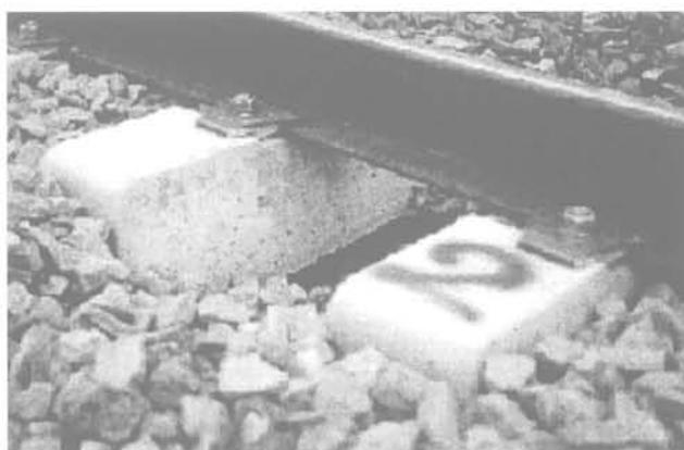
**FIG. 17** Affaissement de la surface du remblai SNCF2 après trafic.
