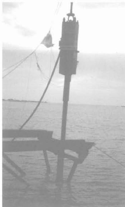
**FIG. 3** Mise en œuvre du système d'ancrage à forte capacité de tenue par battage usuel à l'aide d'un faux pieu tubulaire récupérable en fin d'opération.
