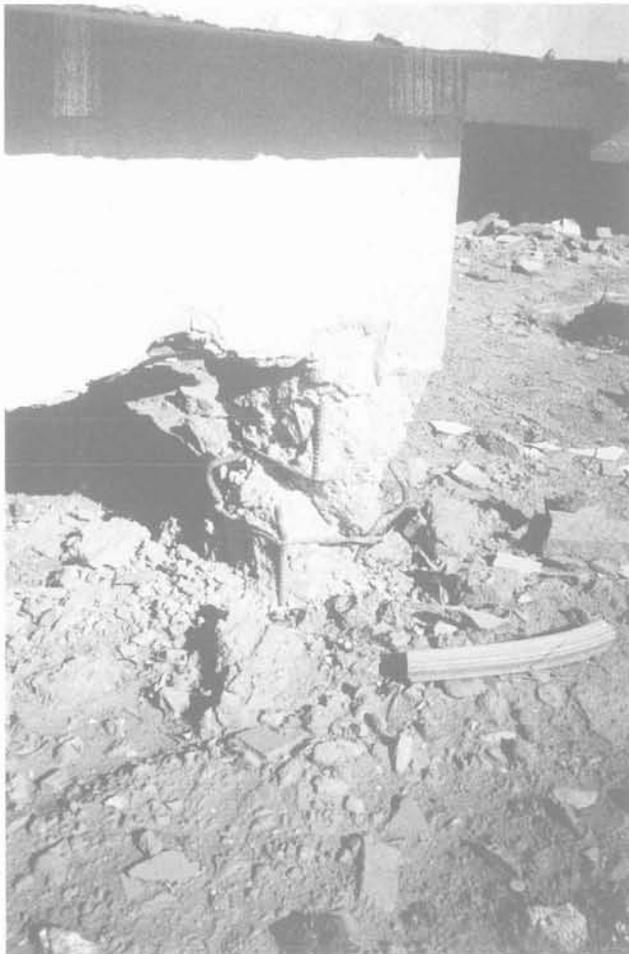
**FIG. 11** Rupture par compression d'un poteau d'angle.
