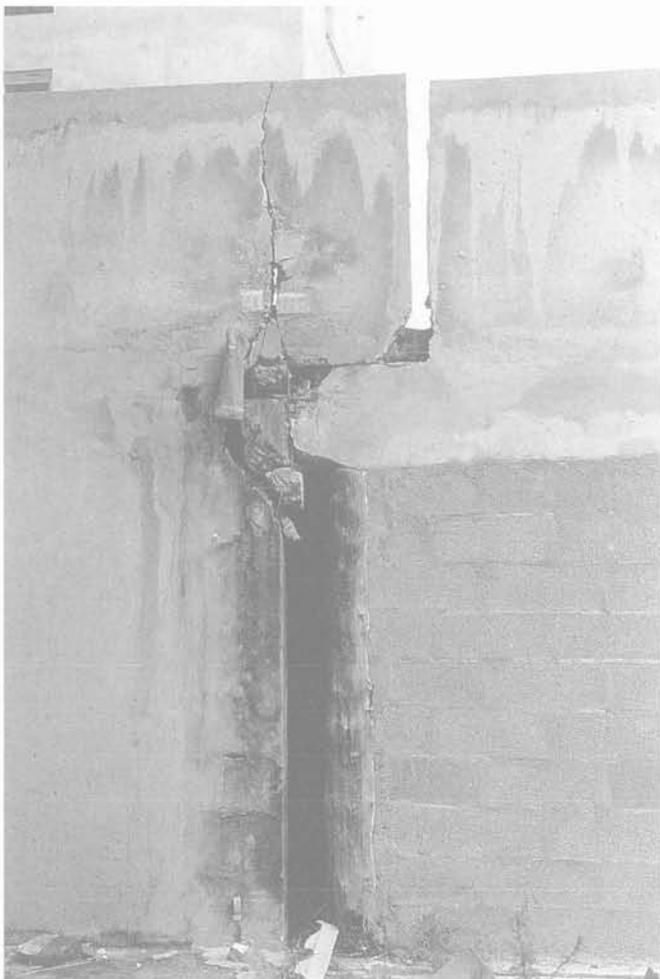
FIG. 3 Désordres de structure à la jonction du bâtiment A et des garages.
