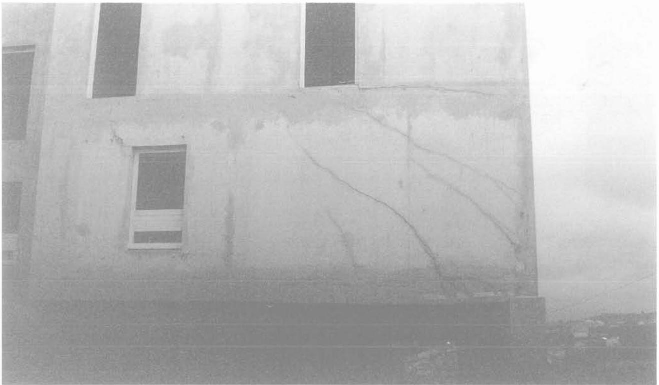
FIG. 2 Fissures caractéristiques de tassements différentiels.
