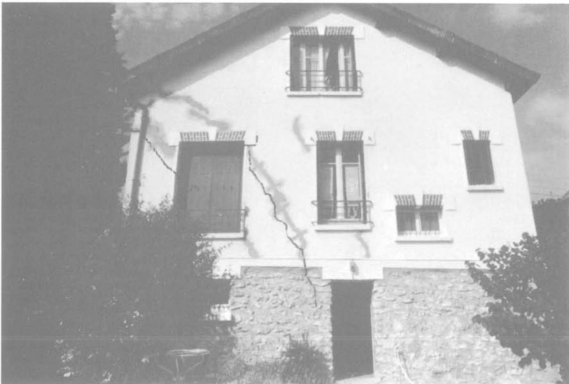
Fig. 6. — (Cliché SIMECSOL). La fissure de l'année 1985 a été colmatée, on a repris en sous-œuvre le pavillon partiellement au moyen de puits trop courts ... et en 1989 une nouvelle fissure, parallèle à la précédente est apparue. Pavillon situé à Montgeron (Essonne) et fondé sur les argiles vertes.
