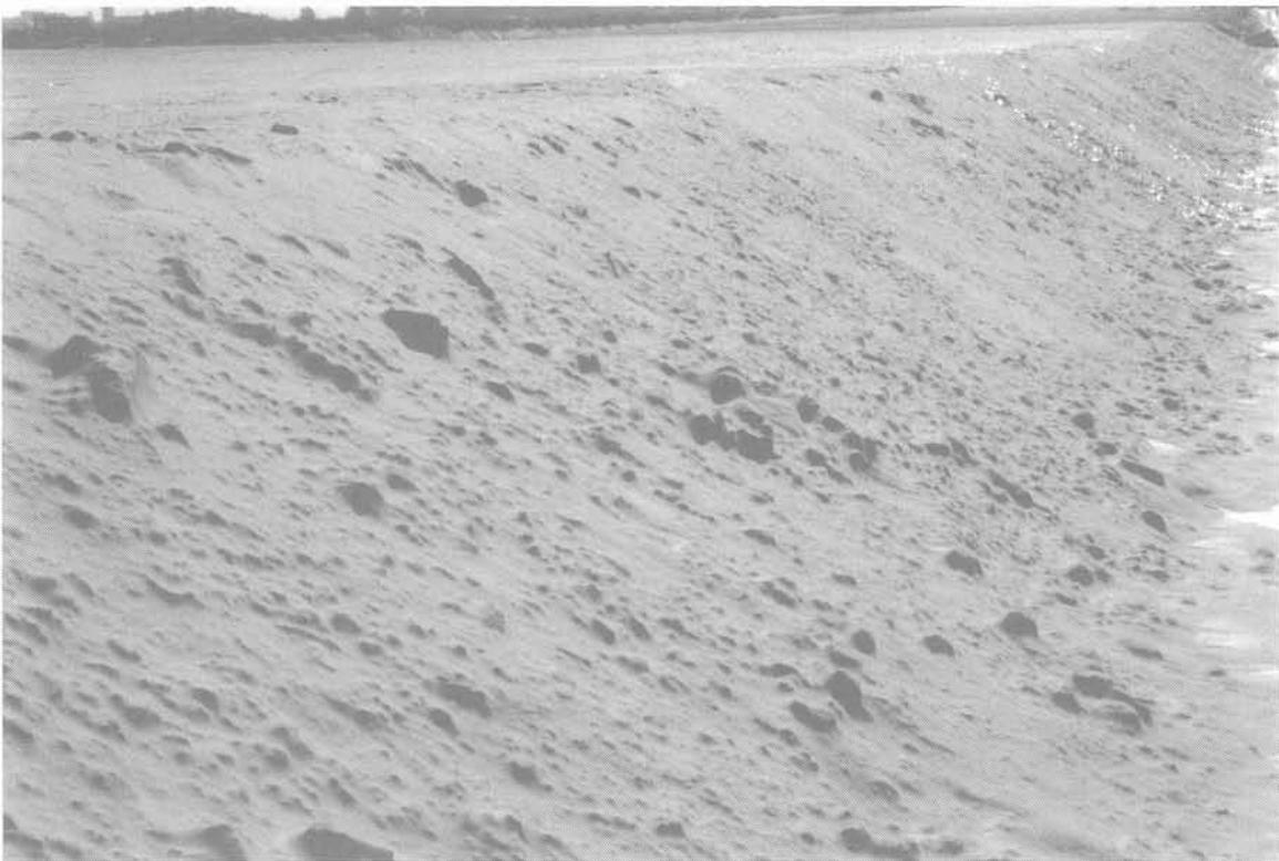
Fig. 16. — Un remblai sous vide.
