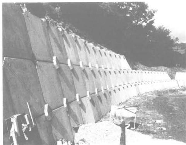
Fig. 13. — Stabilisation d'un déblai à Tarare (Rhône) par panneaux béton préfabriqués cloués au terrain (limons argileux).
