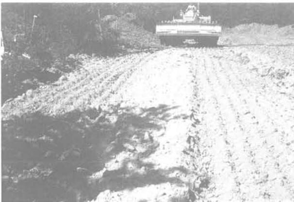
Fig. 5. — Planche d'essais. Premières passes du compacteur 835 sur les marnes dures (teneur en eau inférieure à 10 %).
