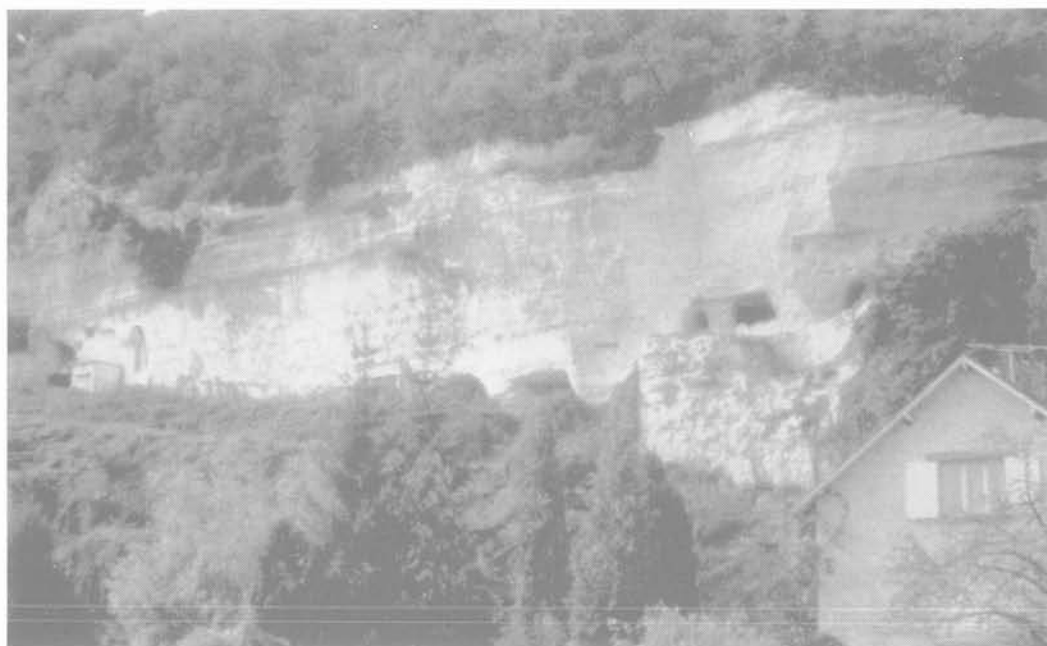
Fig. 4. — Vue d'ensemble du front de falaise. L'entrée de la champignonnière est à l'extrême gauche. A droite, on aperçoit en clair l'emplacement du prisme qui s'est décroché en novembre 1981.
