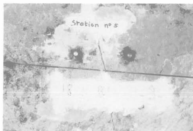
Fig. 7. — Base extensométrique se substituant à un témoin de plâtre.
