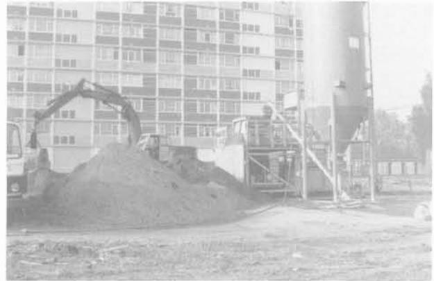
Fig. 23. — Ivry-sur-Seine. Installation d'injection.
