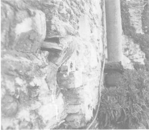
Fig. 2. — Fissures du mur du monastère provoquées par un déplacement horizontal.
