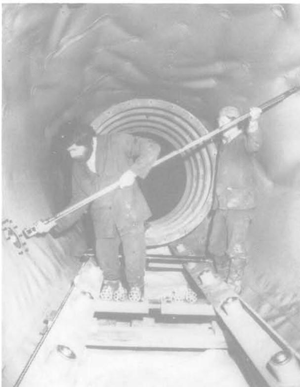
Fig. 14. — Vue de l'intérieur de la chambre pendant le montage des extensomètres radiaux.
