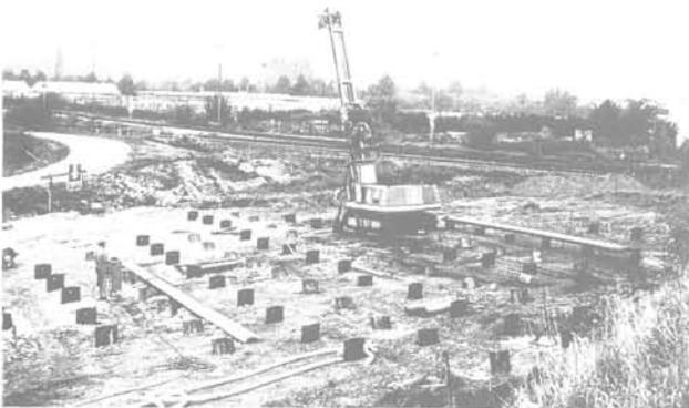
Fig. 14 Chantier d'essai avec armatures enfoncées à travers une couche superficielle
