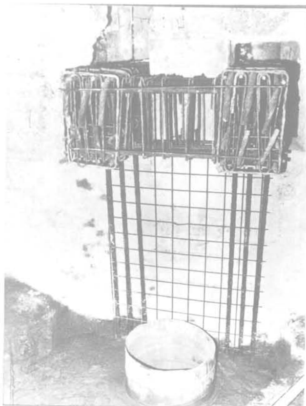
Fig. 8 Armatures des étriers
