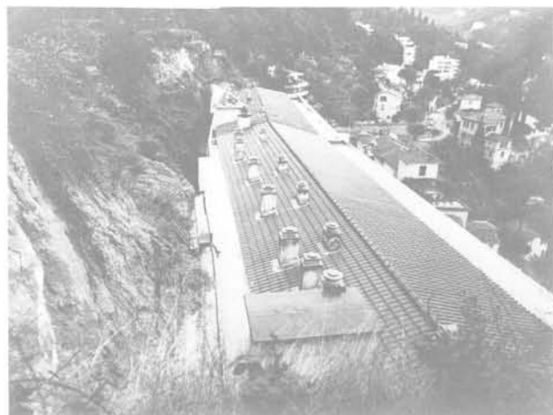
Fig. 14 Le Sacromonte et, au premier plan, l'Escorial quelques heures avant l'effondrement
