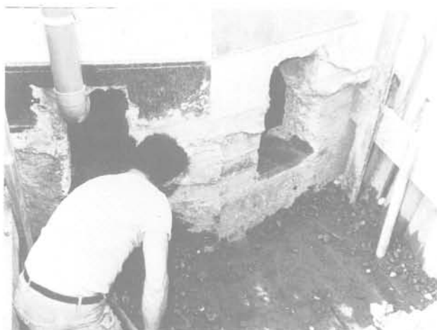
Fig. 7 Percement du voile pour exécution des étriers
