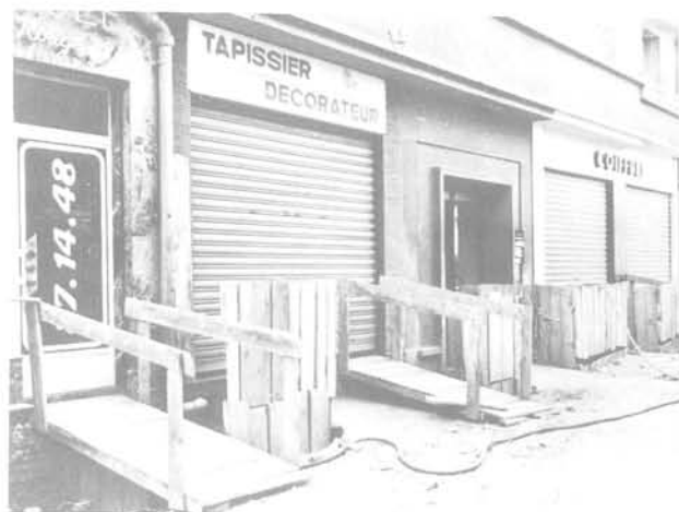
Fig. 6 Fouille pour exécution des étriers
