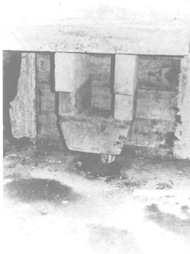
Fig. 11 Calage et fin de fonçage
