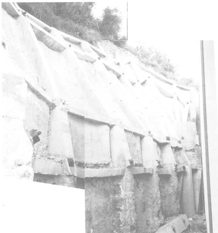
Fig. 20 Ouvrage de soutènement avant finition
