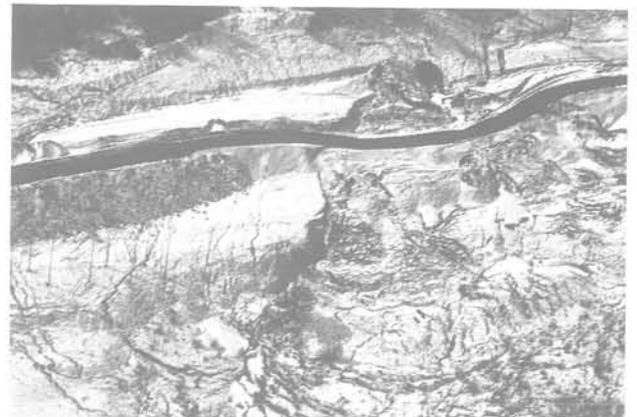
Fig. 21 Glissement d'un remblai construit sur versant instable (Document LRPC Nancy)
