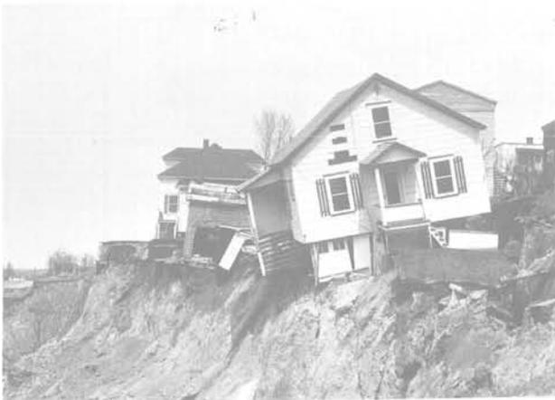
Fig. 18 Glissement d'une découverte de mine à Asbestos, Québec (Document Service Géotechnique MER)
