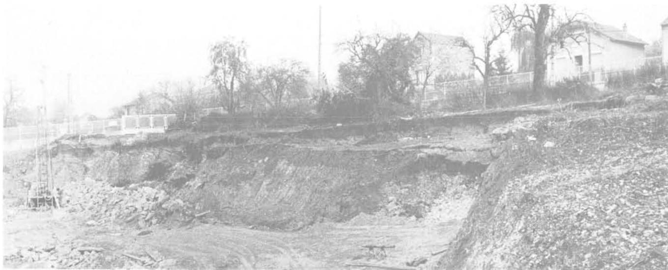
Fig. 16 Réactivation de glissements anciens à l'ouverture de fouilles de bâtiments (Silleran, 1981)
