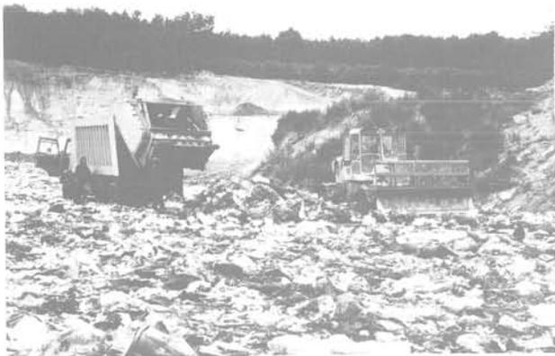
Fig. 2 Mise en dépôt de déchets ménagers dans une décharge contrôlée
