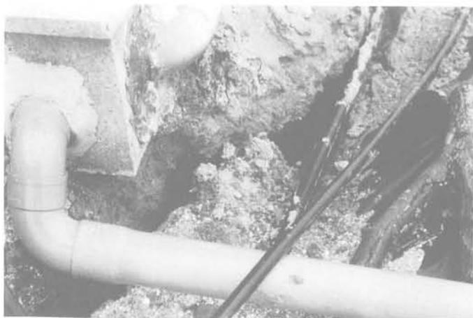
Fig. 7 - La rupture au pied de la façade (B)
