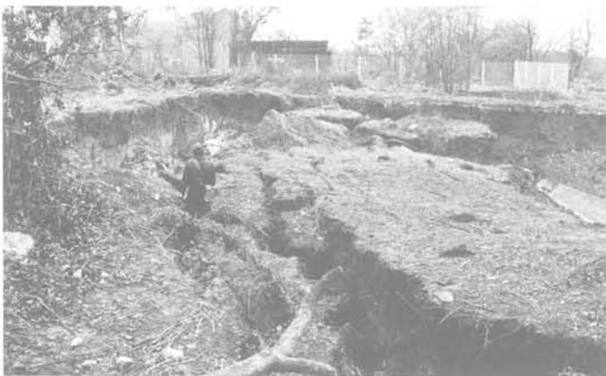
Fig. 3 - La dénivellation au droit de la rupture.
