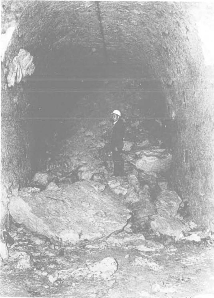
Fig 9 : Galerie en état en limite d'effondrement
