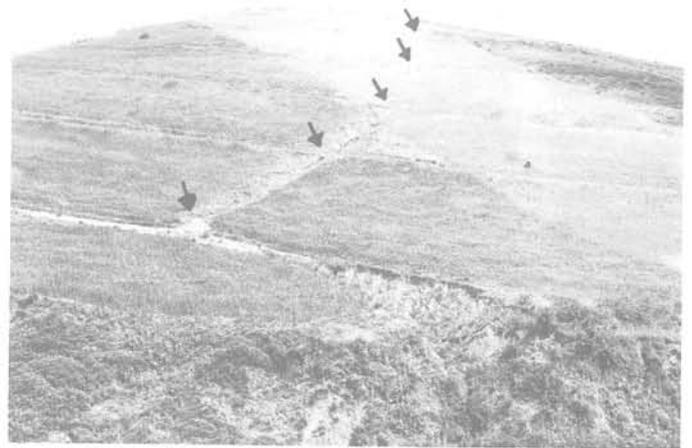
Fig. 3 - Coupure des banquettes par glissement du talus et du bourrelet, puis ravinement. Le phénomène a débuté au bas de la pente, puis par érosion régressive a gagné en amont ; la banquette la plus haute est à peine entamée (Borj Menaïel).
