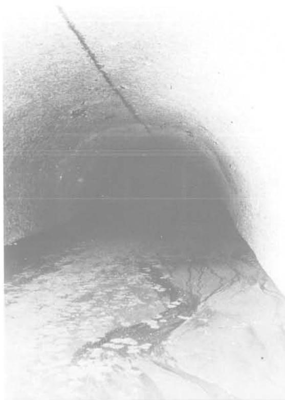
Fig 11 : Le coulis en cours de mise en oeuvre dans une galerie (photo SAE)
