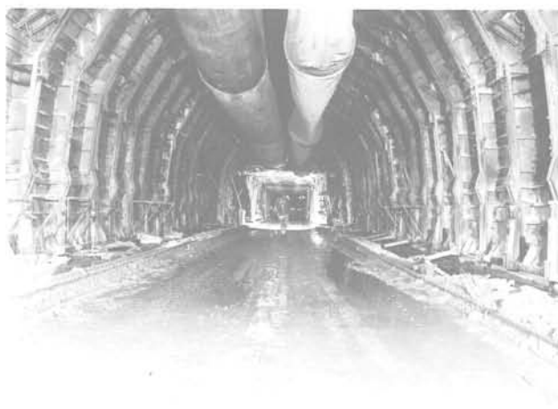
Fig. 29 Bétonnage de la voûte
