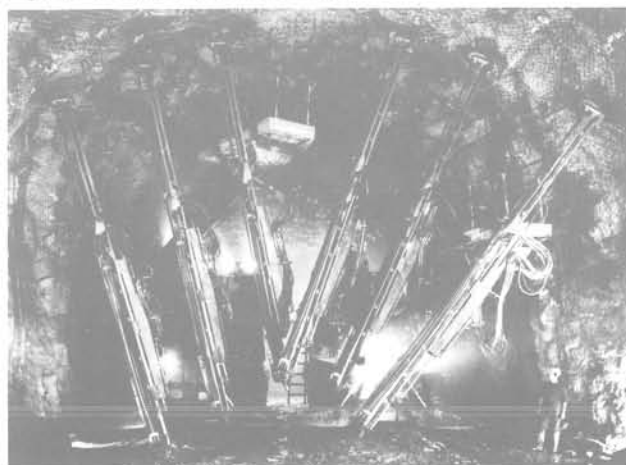
Fig. 26 Boulonnage de la voûte
