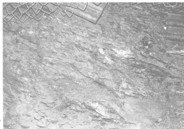
Fig. 14 Faciès phylliteux des schistes lustrés. Aspect du parement au PM 5087
