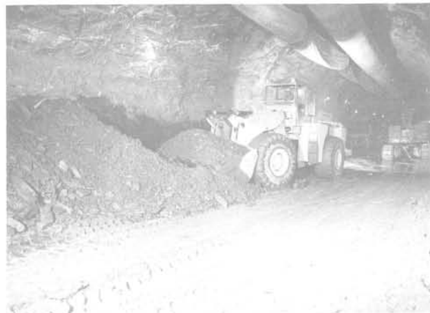
Fig. 25 Mise en cordon des déblais
