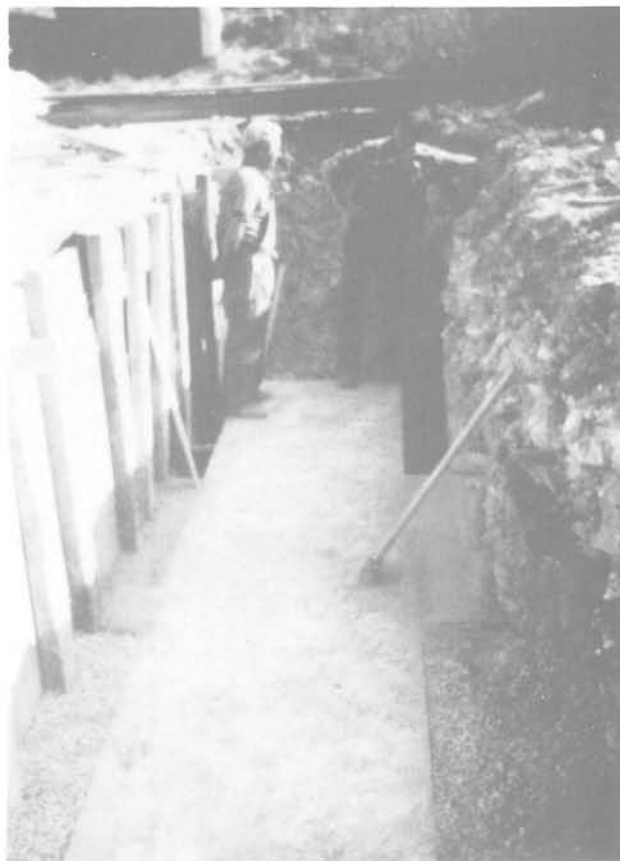
Fig. 19 Tranchée n°3. Bloc PTT
