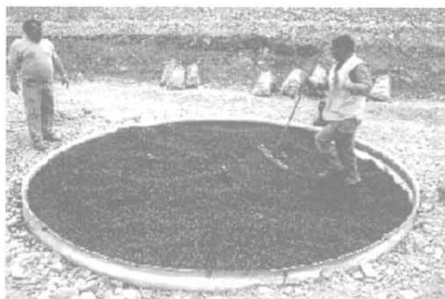
FIG. 2 Cavité de 4 m remplies de billes d'argile expansées.
