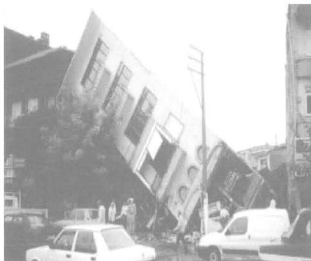
FIG. 1 Exemples de sinistres résultant de phénomènes de liquéfaction des sables (Niigata, 1964 ; Izmit, 1999).
