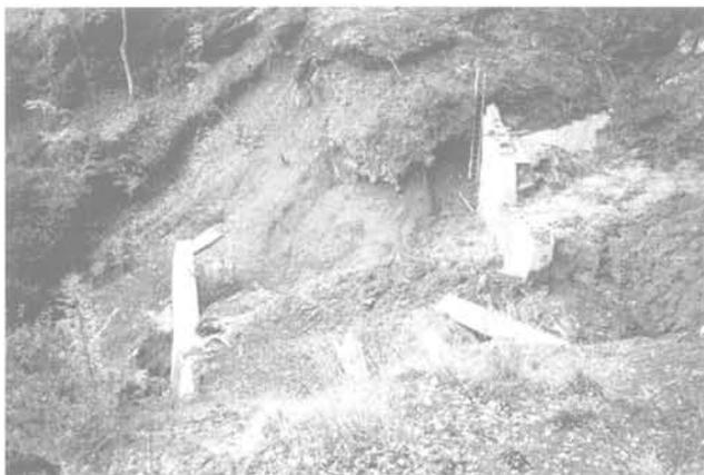
**FIG. 1** Action d'une berge instable sur un barrage de correction torrentielle de type consolidation.
