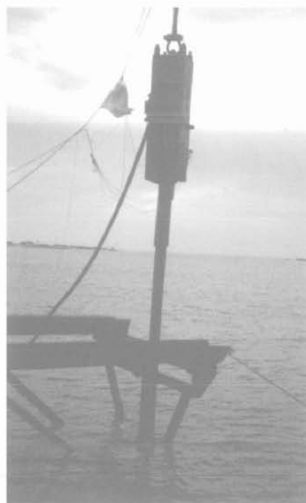
FIG. 3 Mise en œuvre du système d'ancrage à forte capacité de tenue par battage usuel à l'aide d'un faux pieu tubulaire récupérable en fin d'opération. Installation of the high holding capacity anchoring system using standard pile driving techniques with a follower, recovered after installation.
