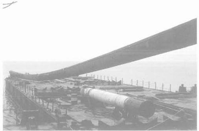
FIG. 7 Levage d'un pieu battu.
