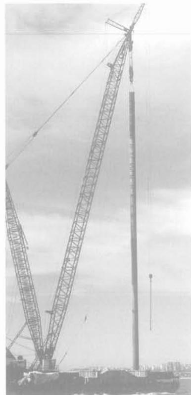
FIG. 8 Mise en fiche d'un pieu battu.
