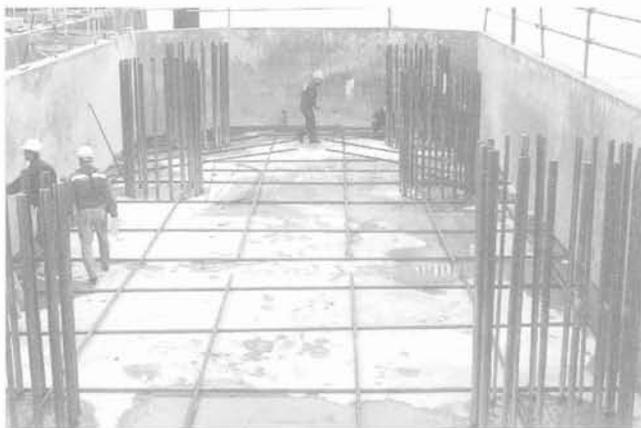
FIG. 10 Vue intérieure d'un caisson de fondation avec la partie supérieure des cages d'armatures des pieux battus.
