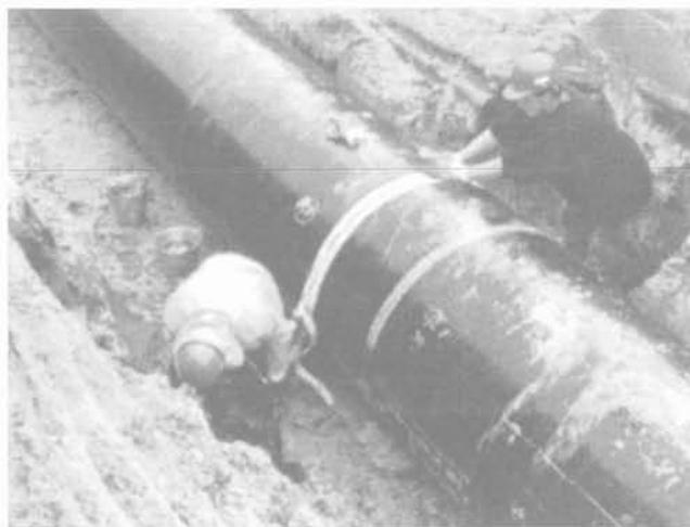
PHOTO 4 Mise en place des ancrs de kevlar.
