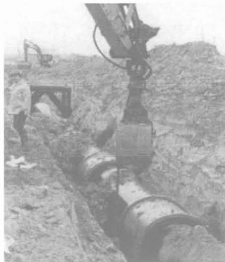
PHOTO 6 Remblayage de la conduite.
