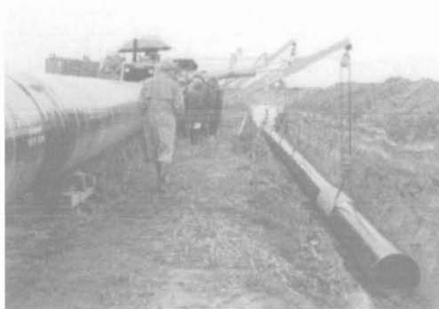
PHOTO 2 Mise en place de la conduite.
