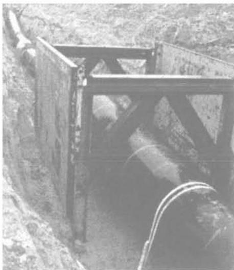
PHOTO 5 Les ancres et les sangles sont installées.
