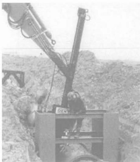
PHOTO 3 Battage des ancrs, la conduite étant protégée par un châssis.
