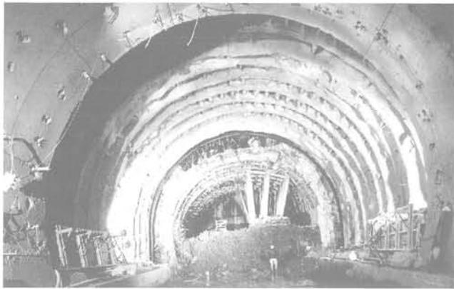
FIG. 5 Tunnel San Stefano : effondrement de la cavité.
