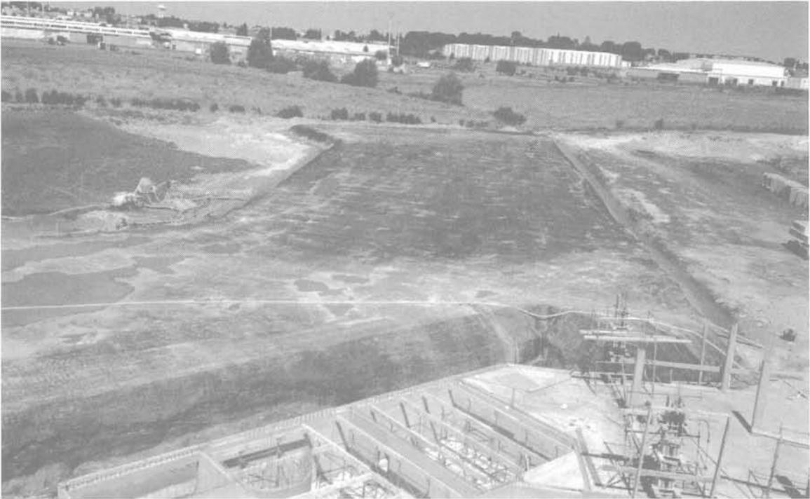
Fig. 15. — Membrane sous vide à proximité d'un bâtiment sur pieux.
