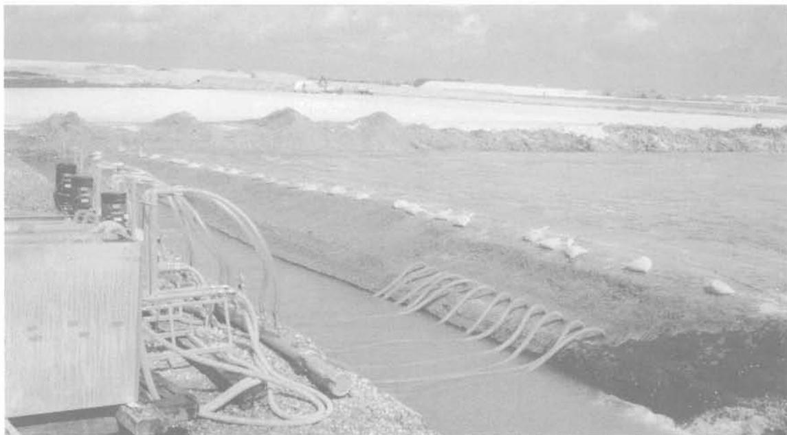
Fig. 4. — Système de jonction entre les drains de surface, les drains profonds et les pompes à vide.
