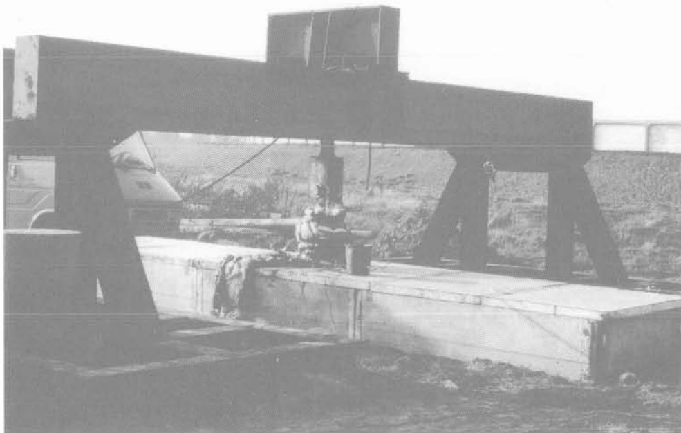
Fig. 3. — Le pieu A et le bâti de réaction.
