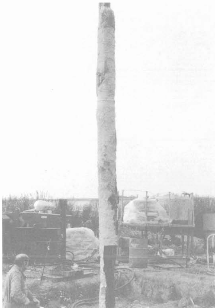
Fig. 7. — Gaine de ciment autour du pieu B. Fig. 7. — Grout sheath around the pile B.
