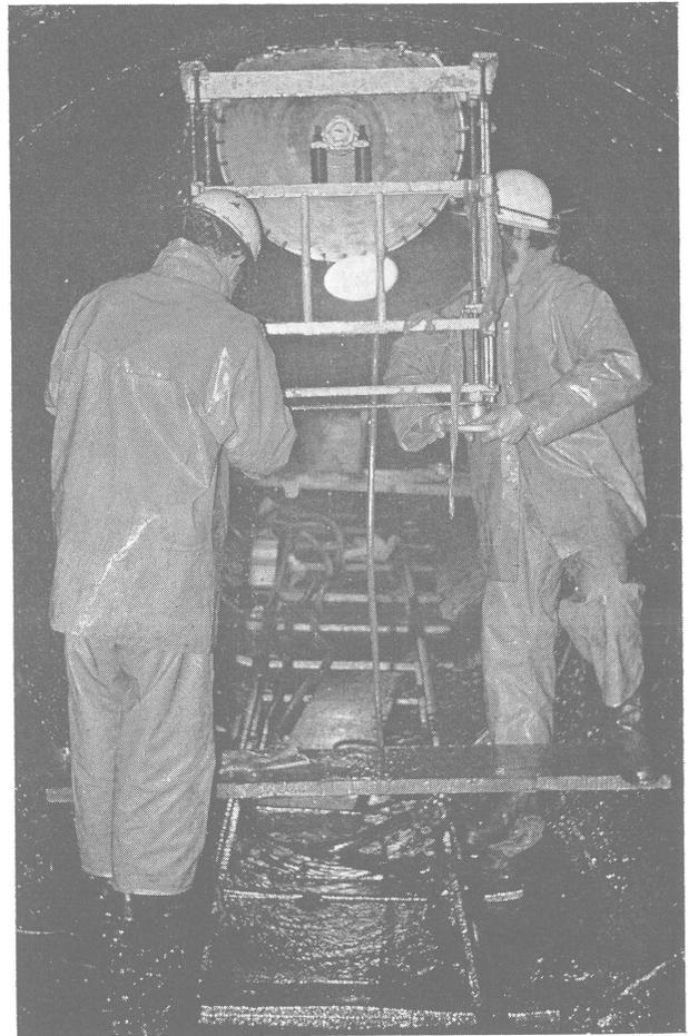
Fig. 2. — Saignée pour vérin plat en toit de galerie.
