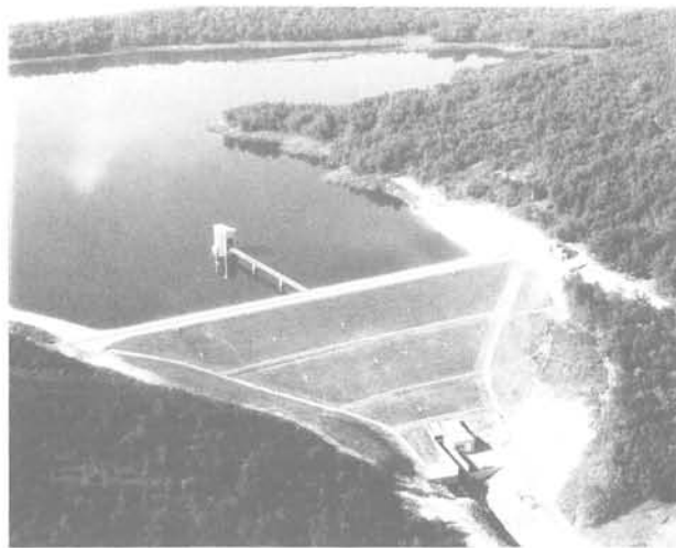
Fig. 2. — Vue du barrage principal.
