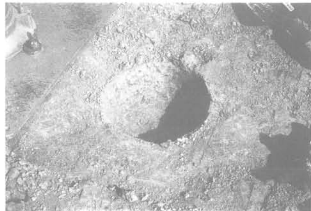
Fig. 7. — Planche d'essais. Trou creusé dans les marnes dures après dix-huit passes du compacteur 835.
