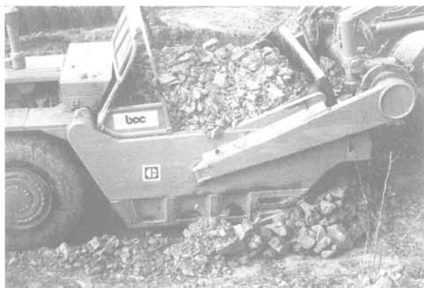
Fig. 4. — Planche d'essais. Prélèvement des marnes dures (partiellement altérées).
