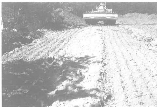
Fig. 5. — Planche d'essais. Premières passes du compacteur 835 sur les marnes dures (teneur en eau inférieure à 10 %).
