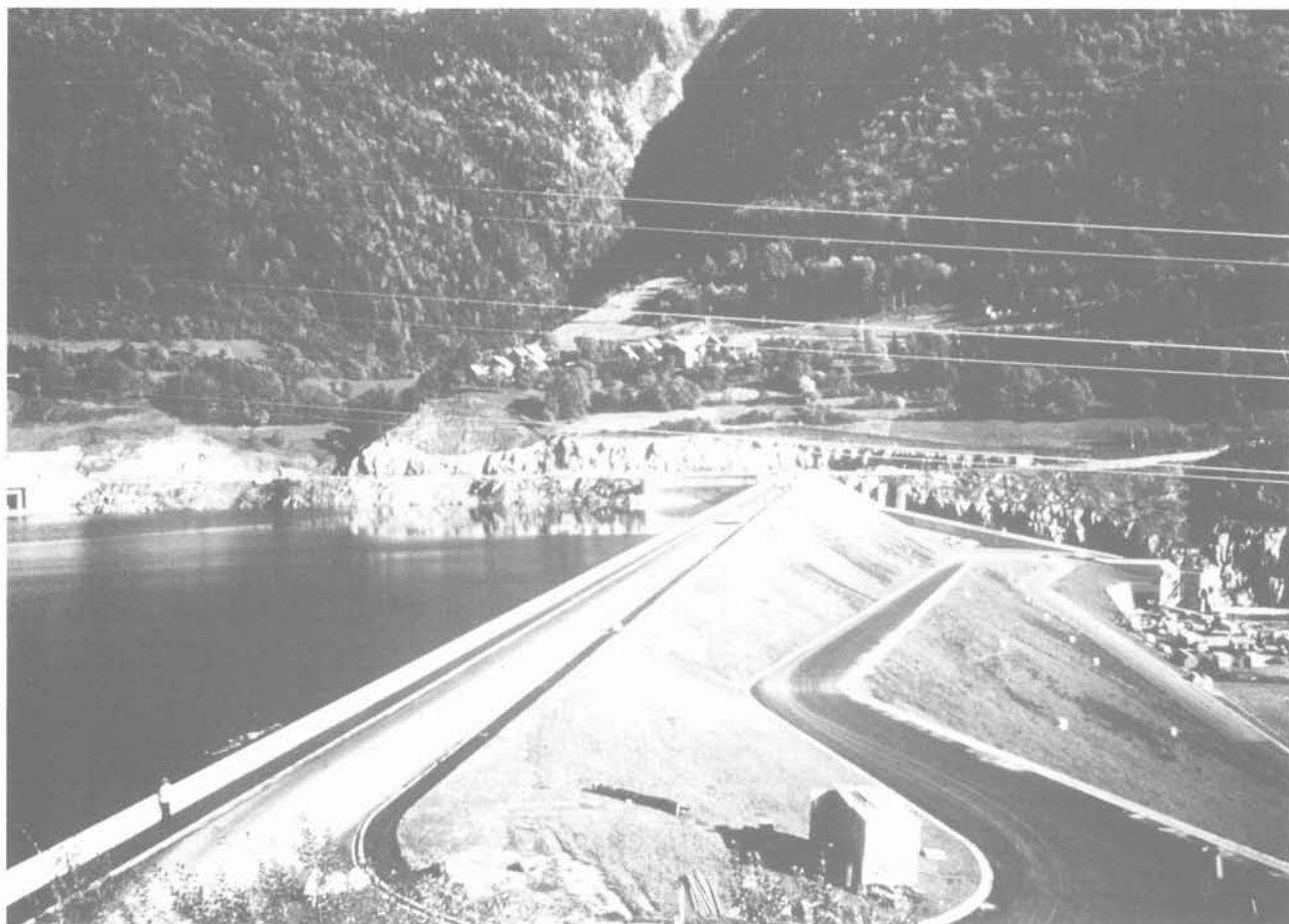
Fig. 1. — Le barrage de Verney en eau.
