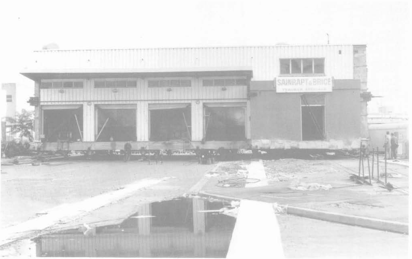
Fig. 14. – Déplacement d'un bâtiment à Rungis. Soulèvement de 1,20 m, puis trajet sans voies ferrées.
