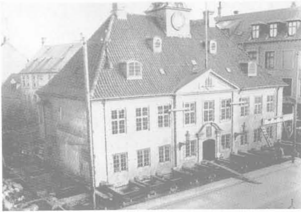
Fig. 6. – Déplacement de l'Hôtel-de-Ville de Randers (Danemark), 1930. Poids 700 tonnes, ripage 3 mètres, soulèvement 7 cm.
