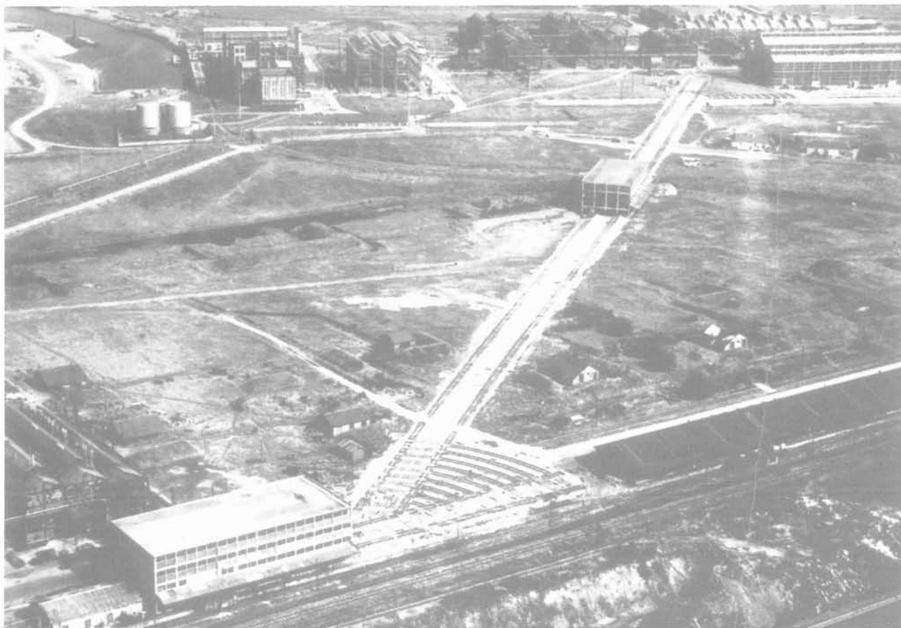
Fig. 18. – Usine Kuhlmann à Oissel. Bâtiment de 5 000 tonnes déplacé sur un trajet complexe.
