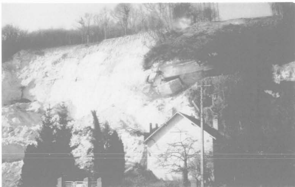
Fig. 14. — Un des derniers tirs d'abattage du surplomb au-dessus de la maison B.
