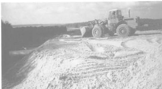
Fig. 5(a). — Remblaiement des buses terminé.
