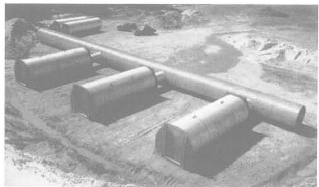
Fig. 3. — Montage des buses avant remblaiement.
