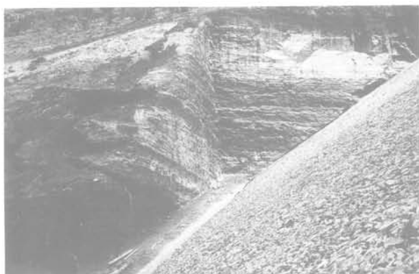
Fig. 30 Barrage «Los Campitos», photographie de la fouille dans l'agglomérat de la rive droite
