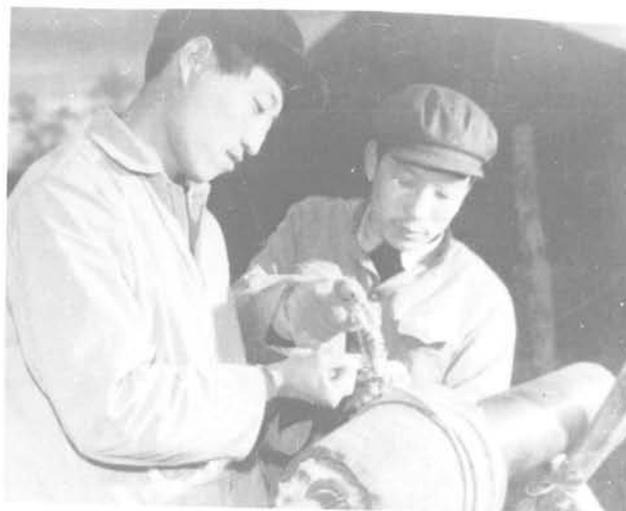
Photo 6 Raccordement sous pression par explosion de la tête d'ancrage intérieure
