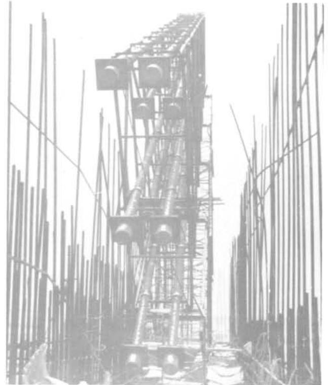
Photo 3 Tirants dans la zone d'appui des vannes-segments
