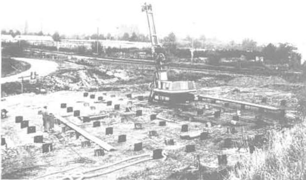
Fig. 14 Chantier d'essai avec armatures enfoncées à travers une couche superficielle
