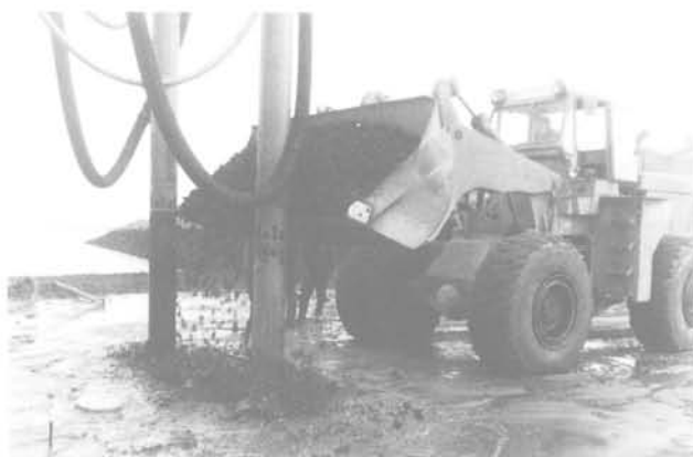
Fig. 10 Mise en place du matériau graveleux dans la colonne ballastée
