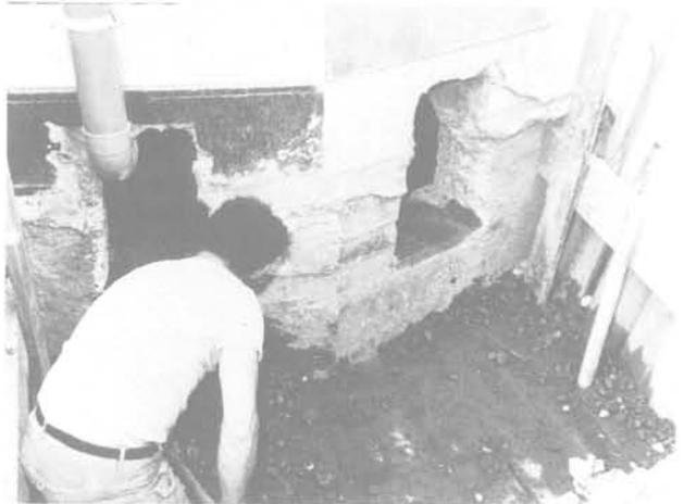
Fig. 7 Percement du voile pour exécution des étriers
