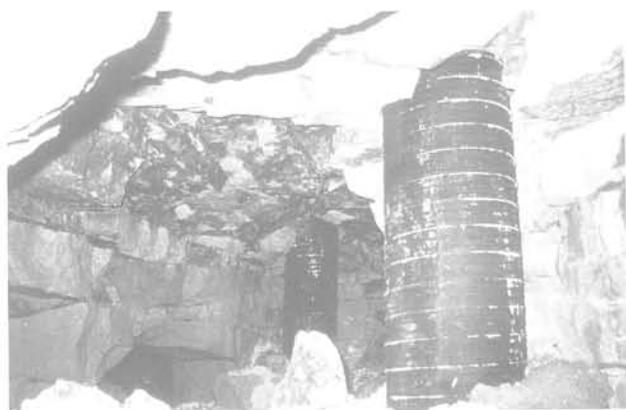
Fig. 8 Exemple de pieux chemisés dans une carrière souterraine (Nord de la France)
