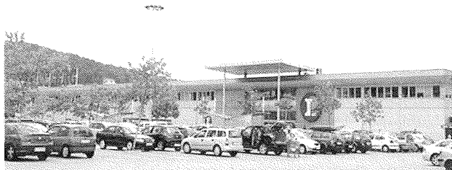
FIGURE 1 Photo du bâtiment achevé.
