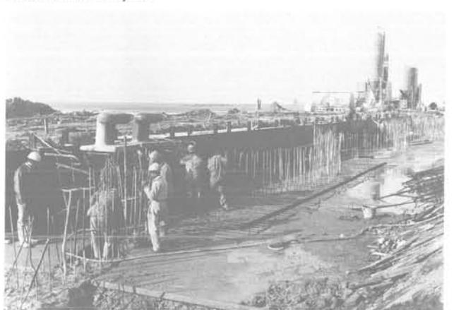
La quatrième phase est le dragage devant le mur : il se déroule durant l'année 1979 (clichés n° 9 et 10). Dans un premier temps d'exploitation de l'ouvrage, la cote de dragage est -12 CM.
