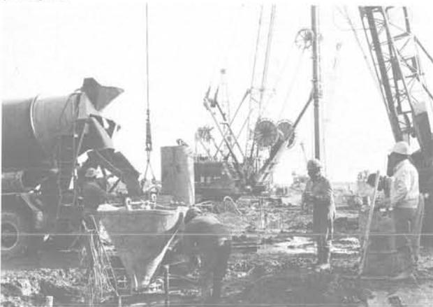
Cliché n° 8 Coffrage et bétonnage de la poutre de couronnement du quai
