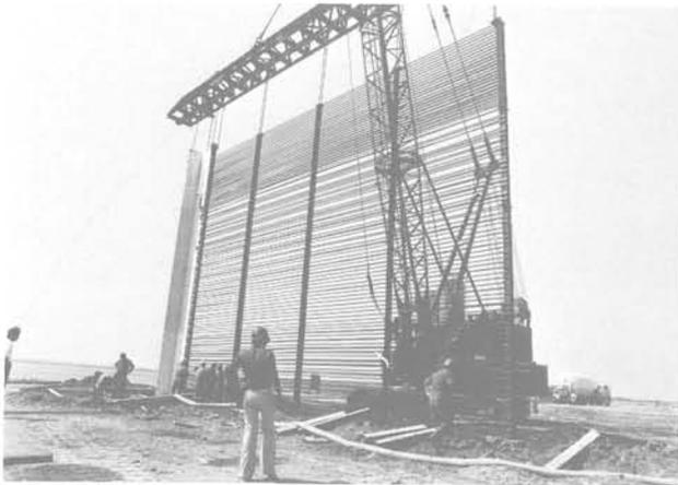
Cliché n° 5 Descente d'un élément d'armature tirant avant, avec pièce de tête et pièce de raccord femelle
