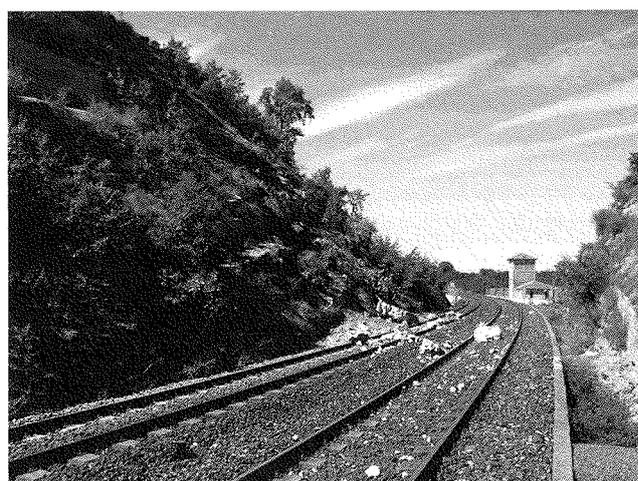
**FIG. 5 Incident en déblai rocheux de type chute de blocs.**
