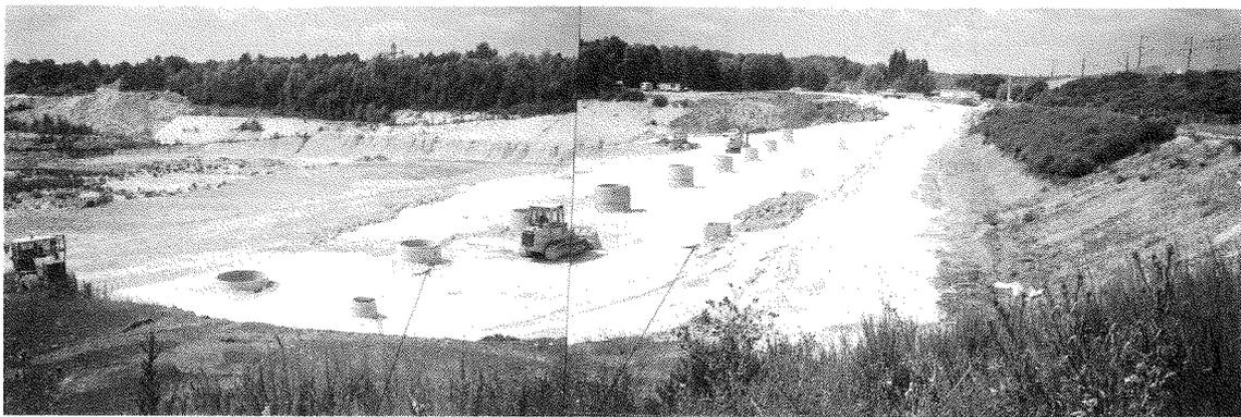
**FIG. 9** Confortement d'un remblai par banquette étagée réalisée par plots et par tranchée et puits drainants.
