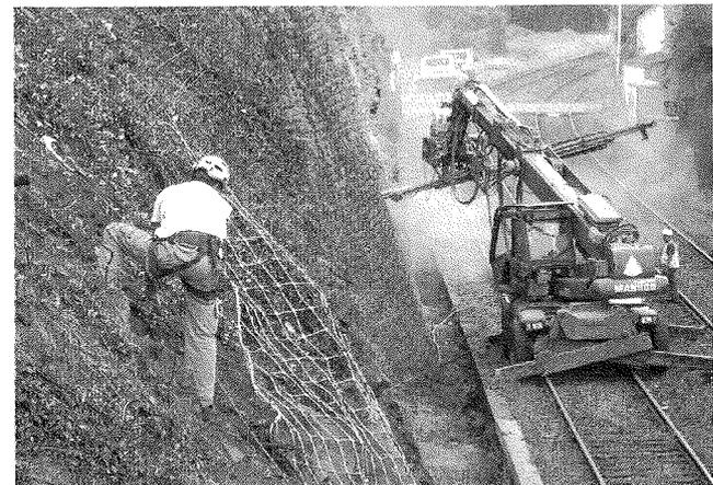
**FIG. 16** Réalisation d'ancrages et mise en place de filets de câbles sur une tranchée rocheuse.
