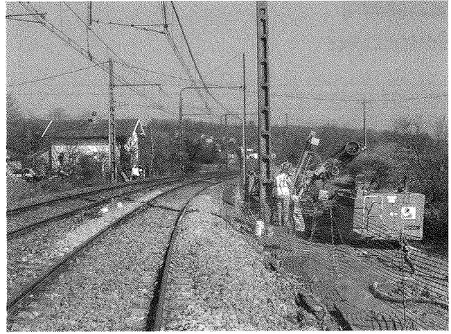
**FIG. 14** Travaux d'injection de sols (forages biais pour ne pas gêner les circulations).
