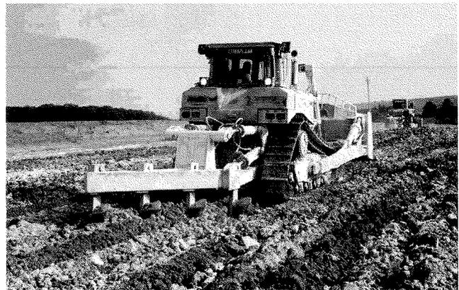
FIG. 6 Traitement à la chaux réalisé à la charrue à socs tractée par un boteur.
