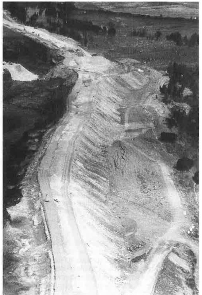
**FIG. 11** Vue vers le nord de la digue glissée et du pied du glissement. Dans ce dernier, on a enregistré un renflement du terrain suivi par la formation de crevasses (qu'on observe au milieu de la photographie).
