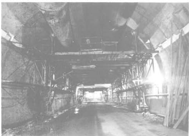
Fig. 30 Bétonnage de la dalle de plafond
