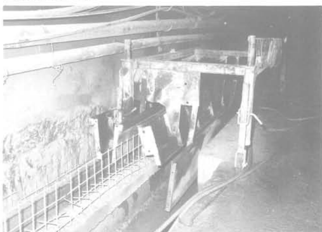
Fig. 31 Bétonnage de la cloison entre les conduits d'air frais et d'air vicié
