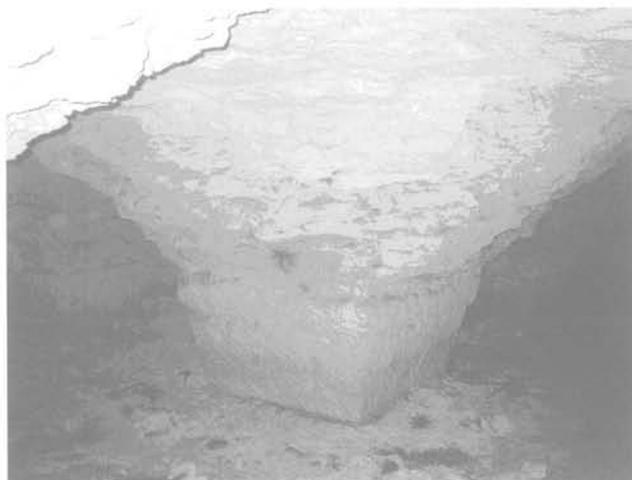
FIG. 6 Pilier tourné dans la masse du calcaire grossier.
