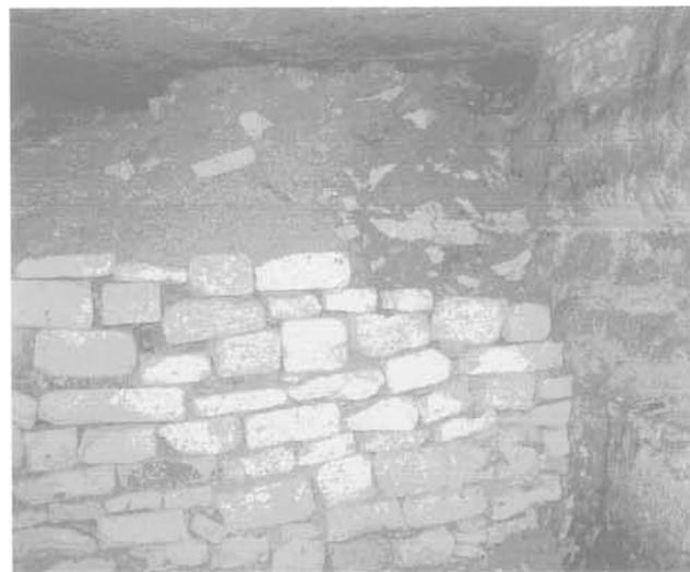
FIG. 8 Hague et bourrage dans une carrière de Calcaire Grossier (LREP).
