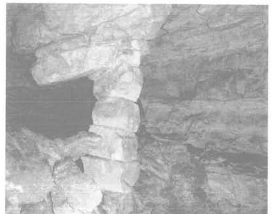
FIG. 10 Tassement différé au droit d'une carrière exploitée par hagues et bourrages (IGC).
