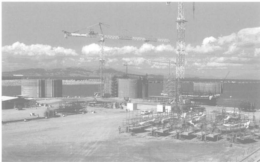
FIG. 1 Le chantier en octobre 2005 : caissons en cours de fabrication. A l'arrière-plan, la digue en caissons. Works in October, 2005: Caissons at precasting yard. See the caissons breakwater in the background.
