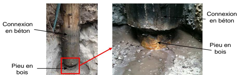
Figure 2. Pieu en bois et connexion en béton
