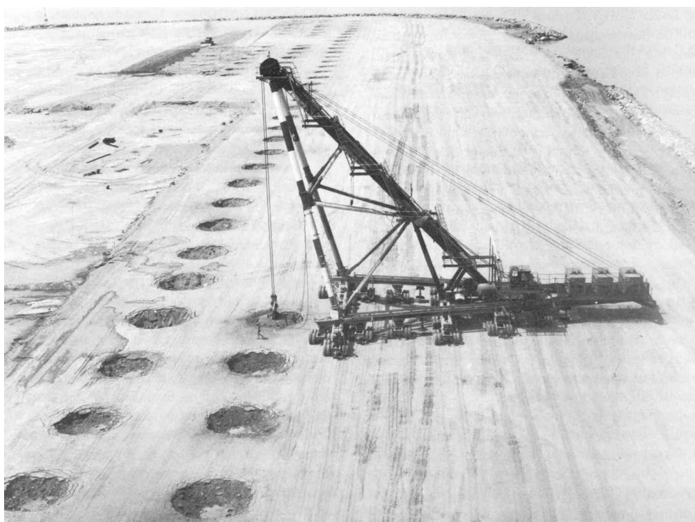
Figure 7. Compactage dynamique sur le chantier de Nice
